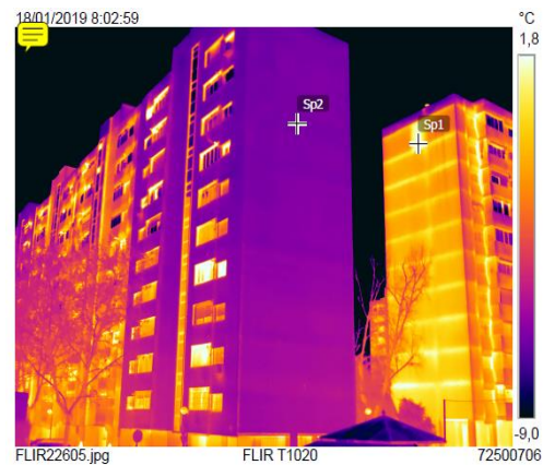
Termografía: Después de obra.
