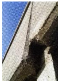
Desprendimiento paneles de fachada.
