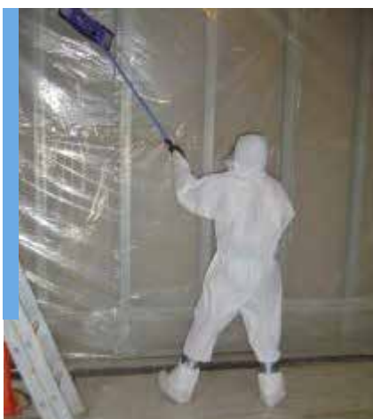
Limpieza utilizando medios húmedos, mopa mojada
