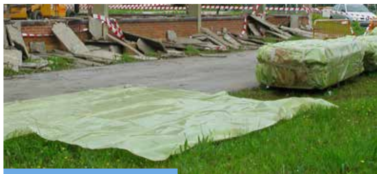
Colocación plástico en la zona de acopio
