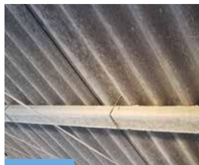
Fibrocemento en buen estado. Material no friable.
