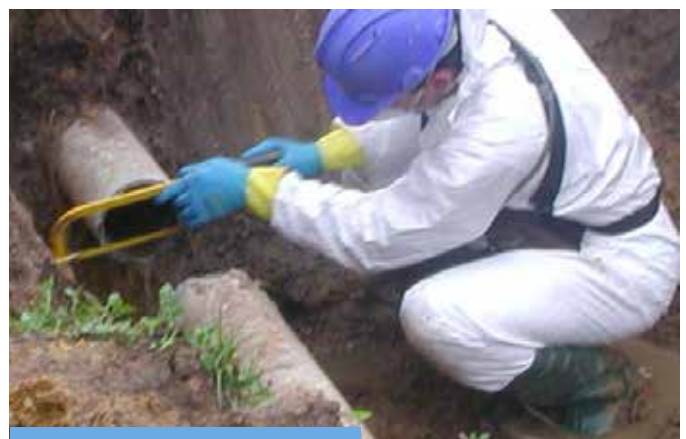
Corte de tubería de fibrocemento mediante sierra manual.
