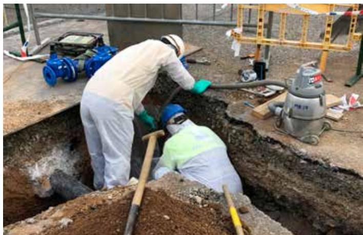
Uso de aspirador en trabajos con MCA
