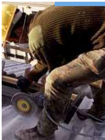
Derecha Corte con radial Izquierda Retirada de amianto
