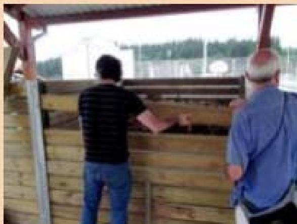
(c) Detalle del sistema de listones para la apertura y cierre de los silos de compostaje
