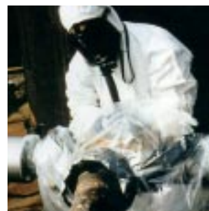
Desamiantado de tuberías.
