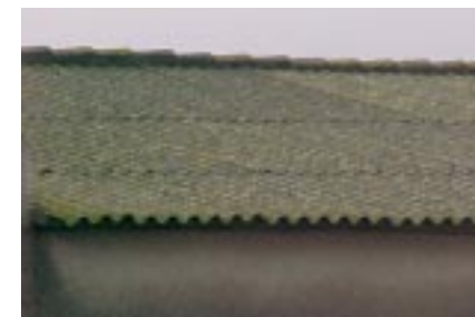
Cubierta de fibrocemento.
