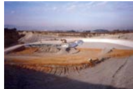
Vertedero de residuos peligrosos.
