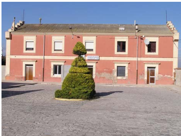
Foto 2.9: Façana a la població de l'edifici de viatgers de Bellpuig, que malgrat les seves dimensions no disposa de personal
