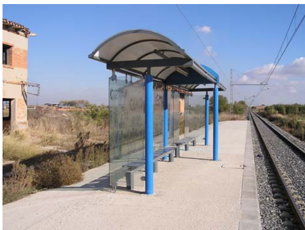
Foto 2.11: Mòduls de marquesina estandaritzats a l'andana de Castellnou de Seana
