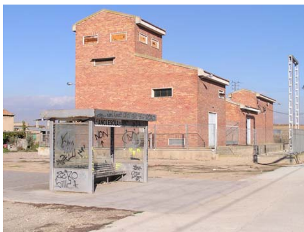
Foto 2.8: Marquesina i sots-central elèctrica
