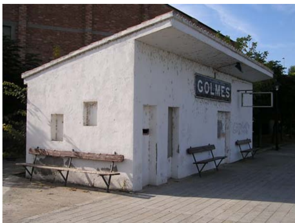
Foto 2.13: Edificació del baixador, actualment tapiada i sense cap ús
