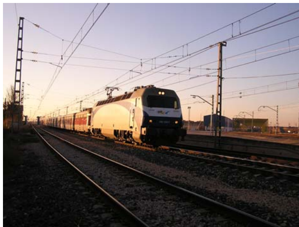
Foto 2.40: Tren Talgo de llarga distància sortint de Puigverd direcció Barcelona, amb les instal·lacions del centre de manteniment de la LAV al fons
