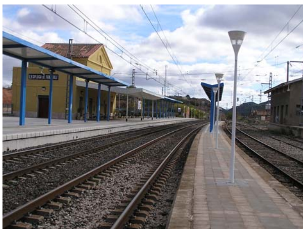
Foto 2.27: Vies de l'estació de l'Espluga de Francolí, vistes des de l'andana de les vies 3 i 5
