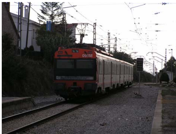
Foto 2.2: El tren sortint cap a Cervera i Lleida. Es pot observar perfectament l'antiga distribució de vies ja que encara hi ha la catenària instal·lada
