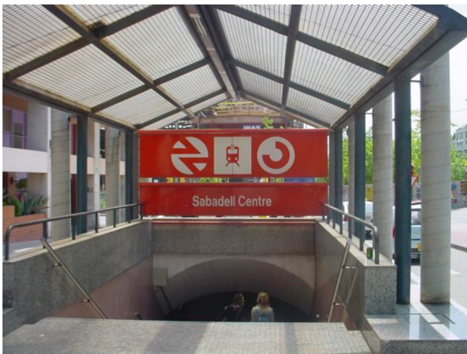
Els dos accessos de l'estació Sabadell Centre
