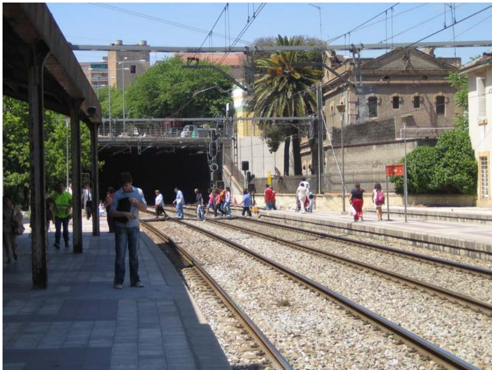
Pas per creuar les vies i el túnel ferroviari al fons
