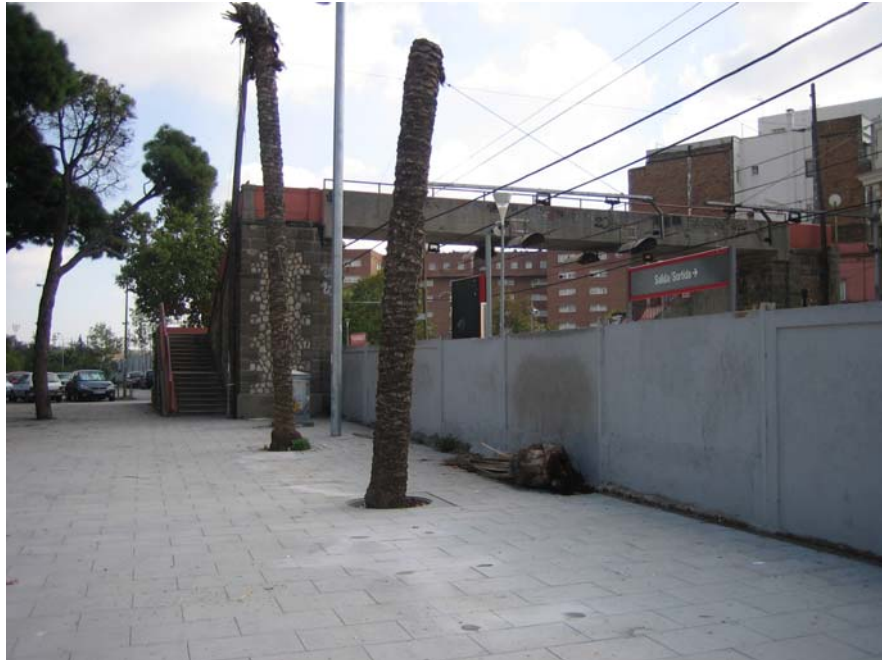
Estació de Cornellà Centre amb el mur que dificulta l'accés a l'andana i la passarel·la al fons
