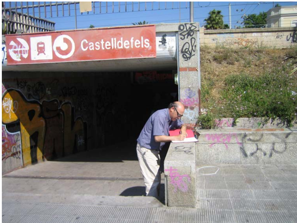
Entrada al pas subterrani per creuar les vies
