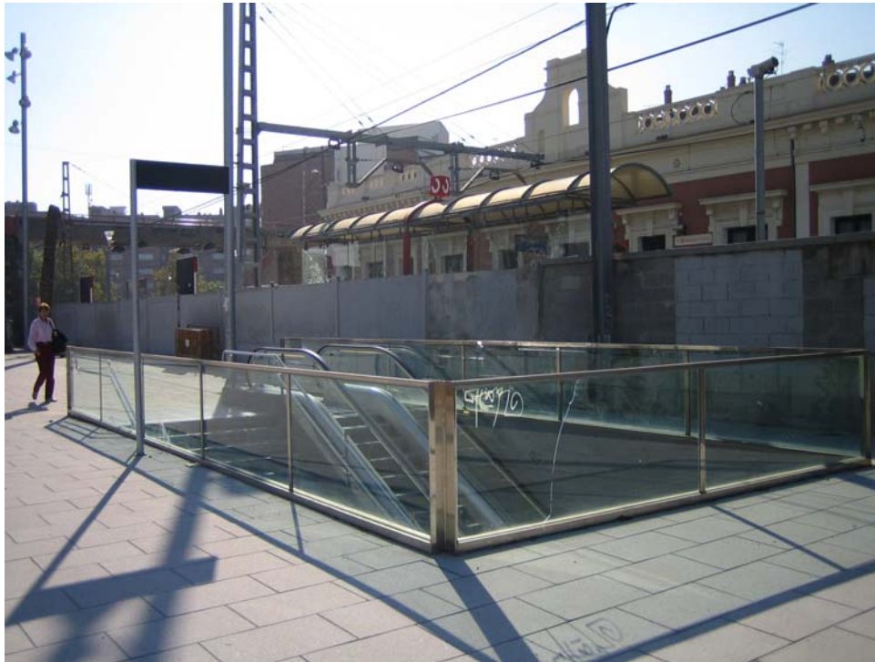
L'accés a l'estació intermodal de metro i tramvia
