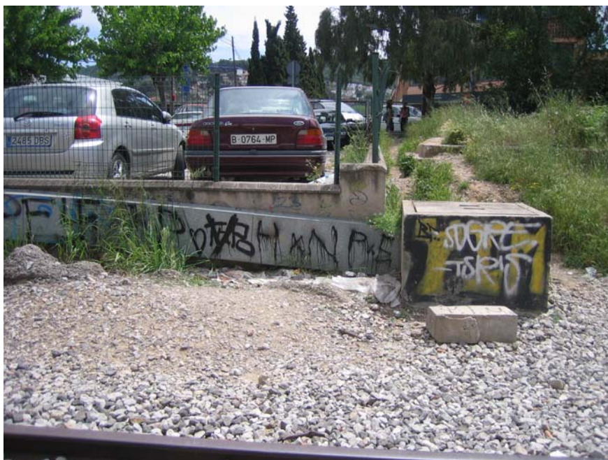
Camí provisional i forat a la tanca del recinte de l'estació
