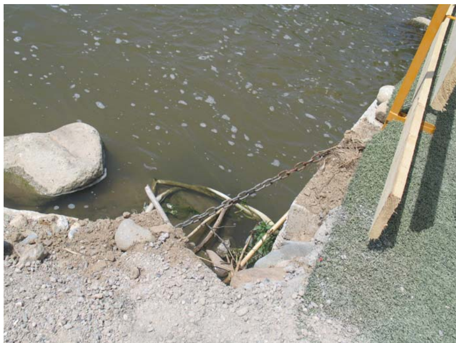
Cadena de subjecció dels taulons de la passarel·la
