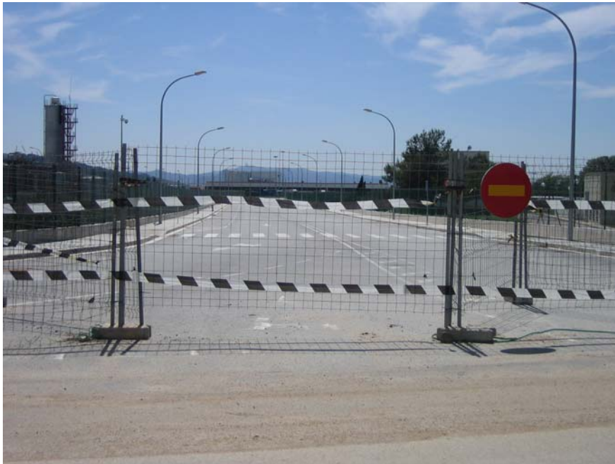
Carrer d'enllaç entre els polígons Can Roca de Martorelles i el de Can Busquerons.
