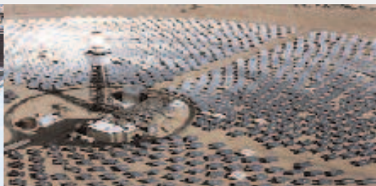
Central solar termoeléctrica de torre.
