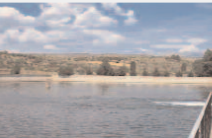
Vistas desde una minicentral hidroeléctrica.
