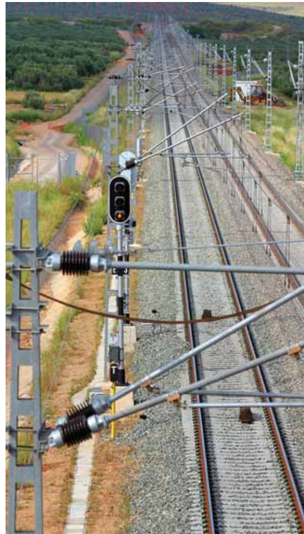
Tramo del AVE Madrid-Jaén.
