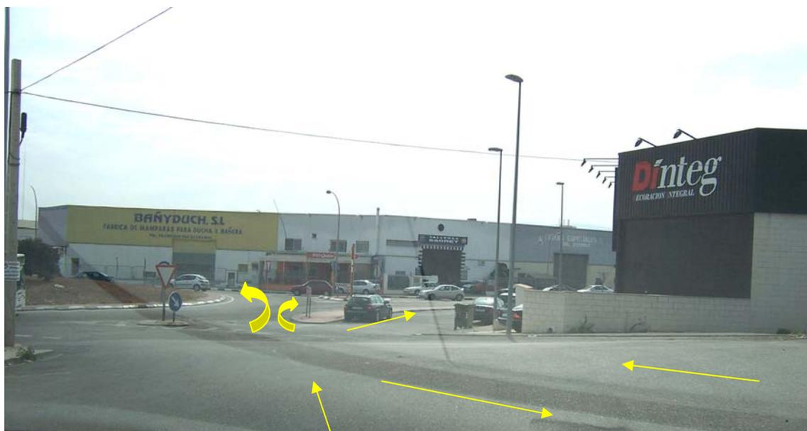
Rotonda central en la CC 320 que pasa por el PI el Real de Gandia. Se puede observar las direcciones que se pueden tomar. No existe una señalización adecuada, y esto puede ocasionar accidentes.
