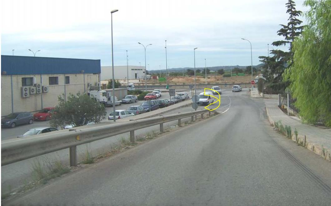
Acceso improvisado al polígono El Oliveral con la finalidad de minimizar el flujo del tráfico por la entrada principal. Pero tal como se puede ver en la foto de abajo las condiciones de seguridad son deficientes carecen de señalización, y los vehículos que por ahí circulan pasan sobre la isleta, con el riesgo de volcar por el desnivel que existe con la vía de al lado.
