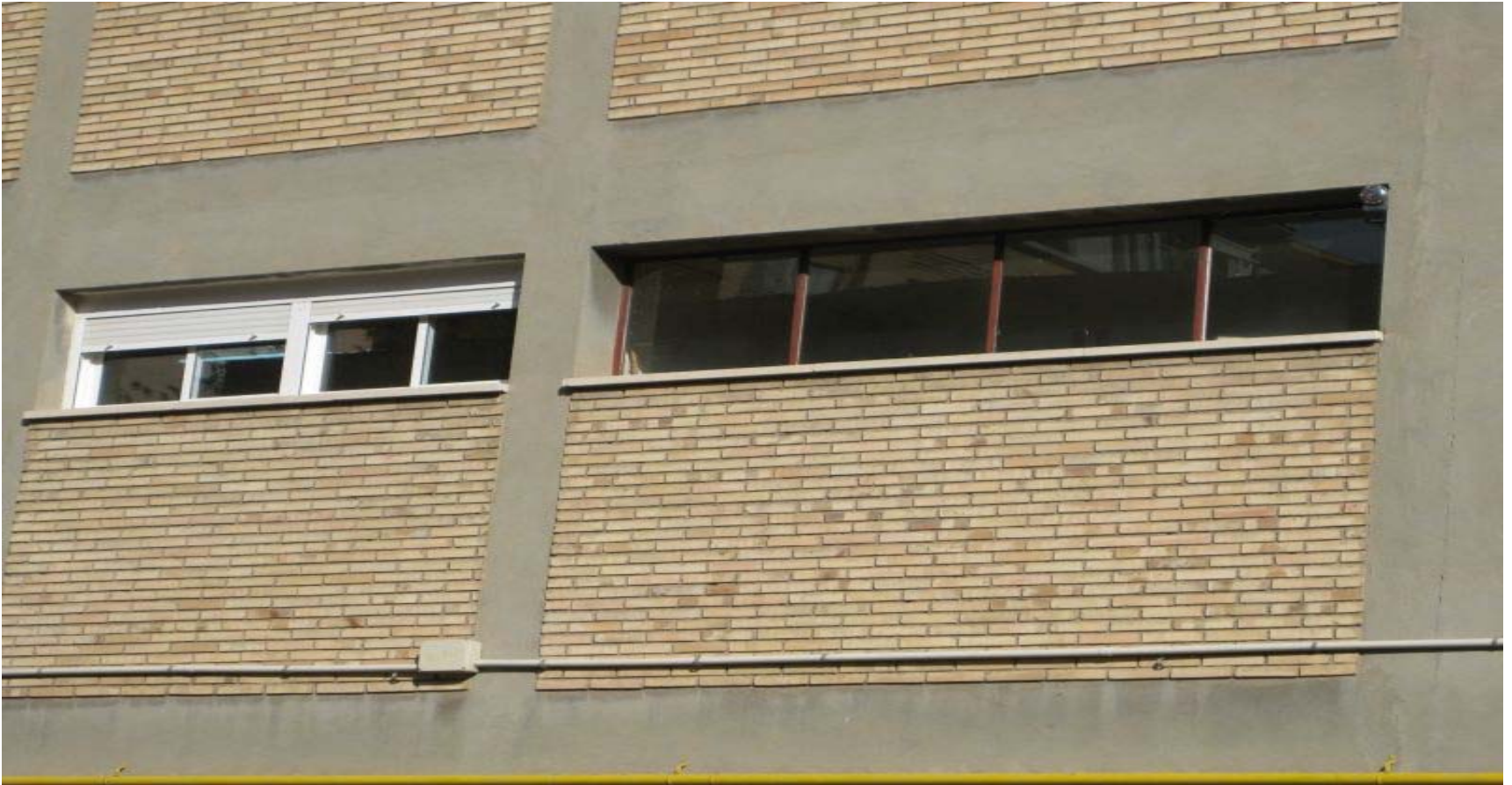
Sustitución de ventanas en el IES Pedro de Luna
